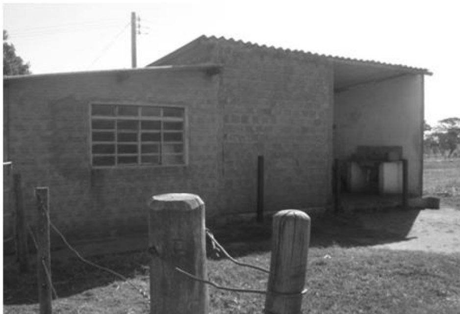
Foto 4 – Padaria e local do tanque de expansão (lote do Croqui 4)
