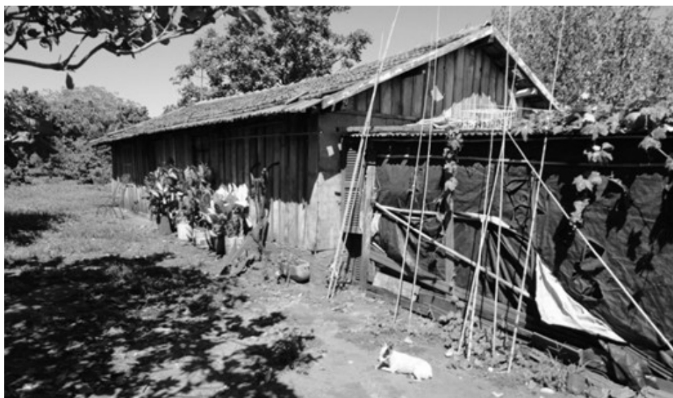
Figura 5 – Exemplar de moradia de madeira e lona no Assentamento Estrela da Ilha, 2012.
