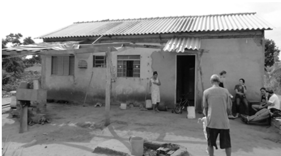
Figura 6 – Exemplar de moradia inacabada no Assentamento Estrela da Ilha, 2012.
