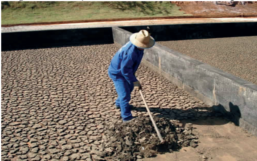
Figura 19 - Remoção manual de lodo de um leito de secagem.
