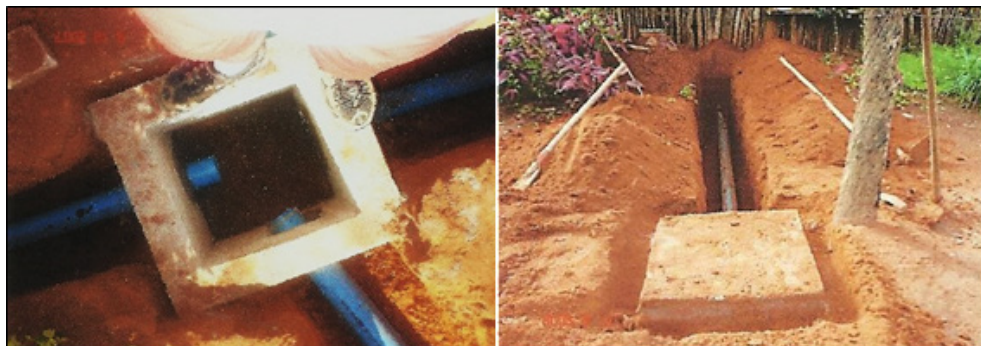
Figura 2 - Detalhe da construção de uma caixa de passagem, caixa pronta e coletor assentado na vala.
