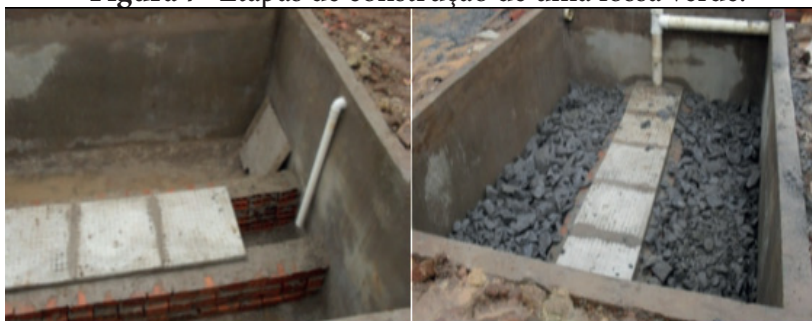
a) Construção da vala e da câmara.
