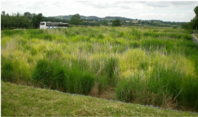
Figura 17 - Vista de um sistema de wetlands operando em Staverton, Reino Unido.
