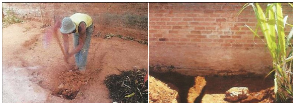
Figura 1 - Abertura manual de vala para coletor simplificado e vala pronta.
