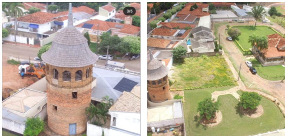
Figura 8 – Vista aérea da torre e do conjunto tombado.
