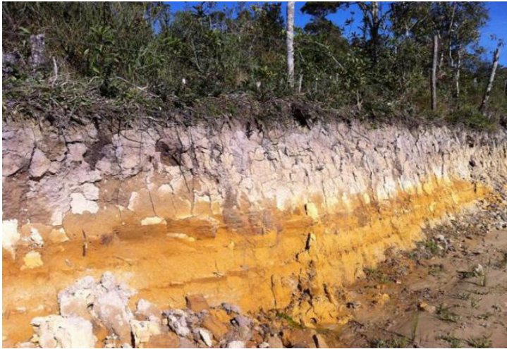
Figura 2 - Barranco e corte de estrada.
