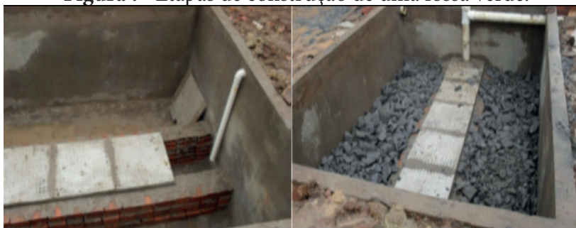
a) Construção da vala e da câmara.
