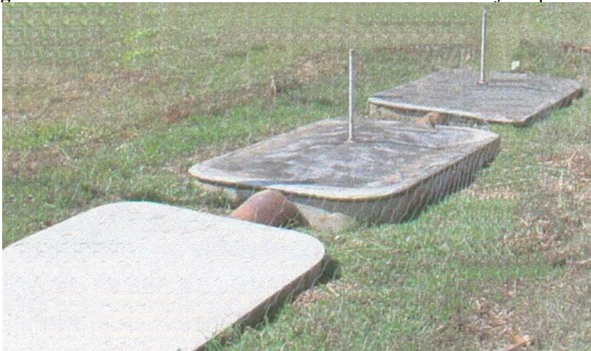
Figura 6 - Vista do sistema de fossas e filtro de fibrocimento já implantado.
