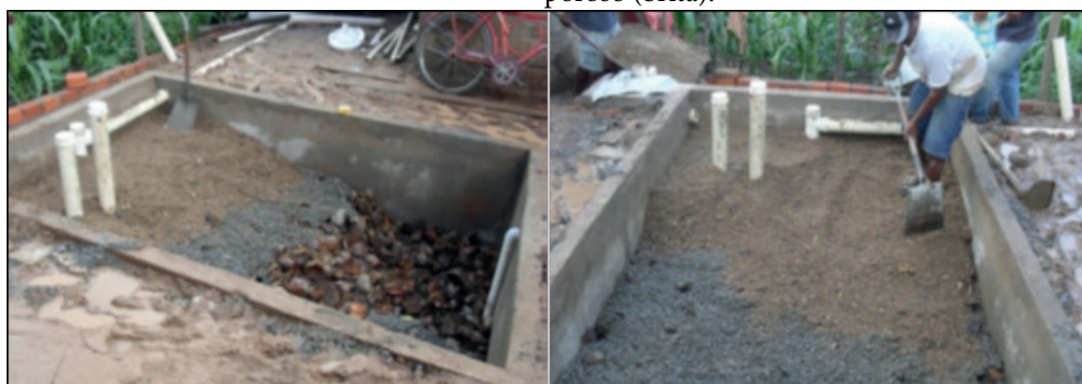
c) Cobertura do filtro com material terroso.
